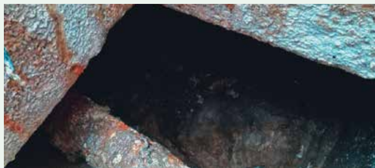
Pogled na kanalizacijski jašek
